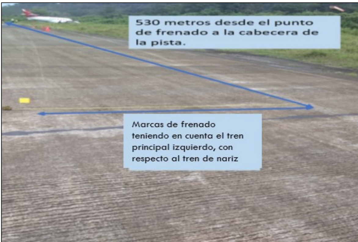
Fotografía No. 12: Marcas de frenado de la aeronave HK4394
