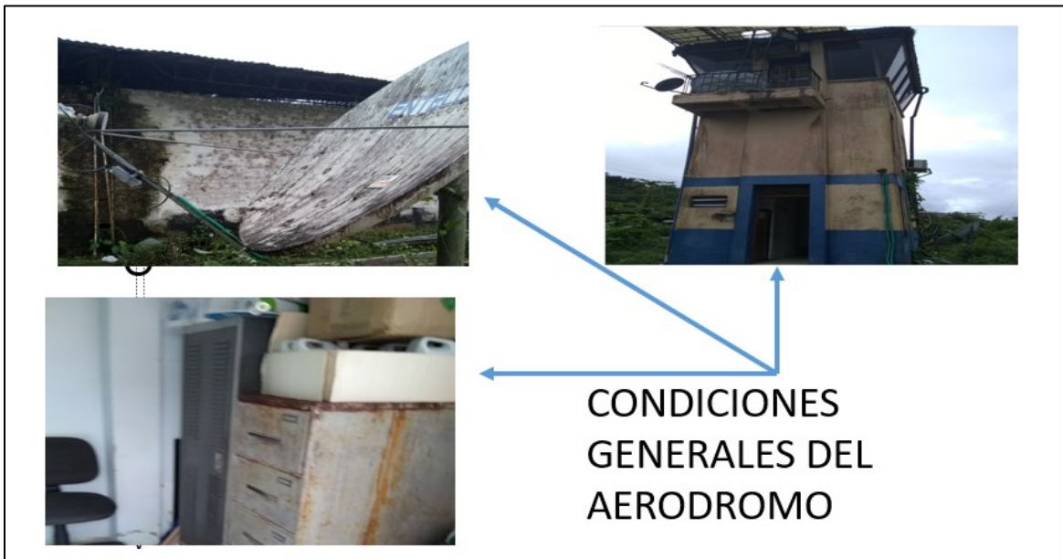
Fotografía No. 10: Condiciones generales de aeródromo
